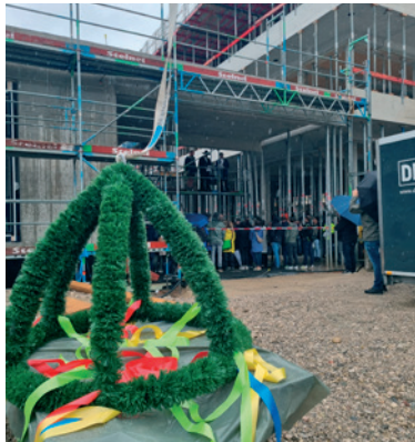
Sichtbares Zeichen des Baufortschritts: Der Richtkranz am neuen Gymnasium Putzbrunn.
